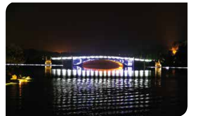
景观照明示范工程
